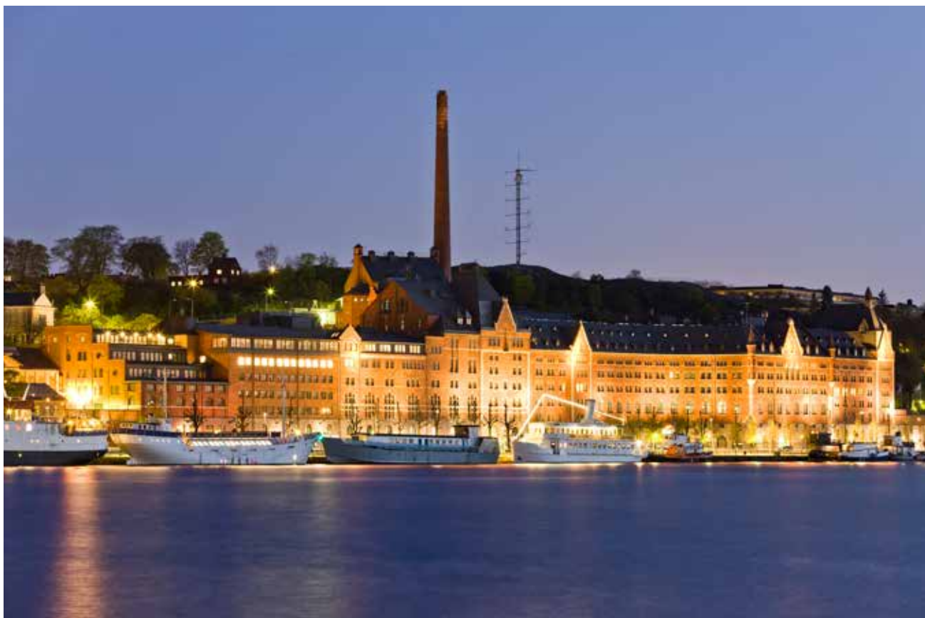
Konferensanläggningen Münchenbryggeriet vid Söder Mälmarstrand i Stockholm använder sjövatten för både komfort- och processkyla samt värme direkt till värmepumparna. Kärnan i systemet är ett borrhålslager med 54 hål à 400 meter.
