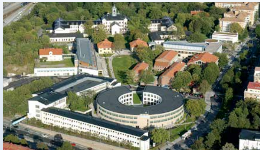
Telia kyler sitt datacenter i Fredhäll i Stockholm med både luft och geoenergi. Värmen nyttjas vintertid av Campus Konradsberg.
