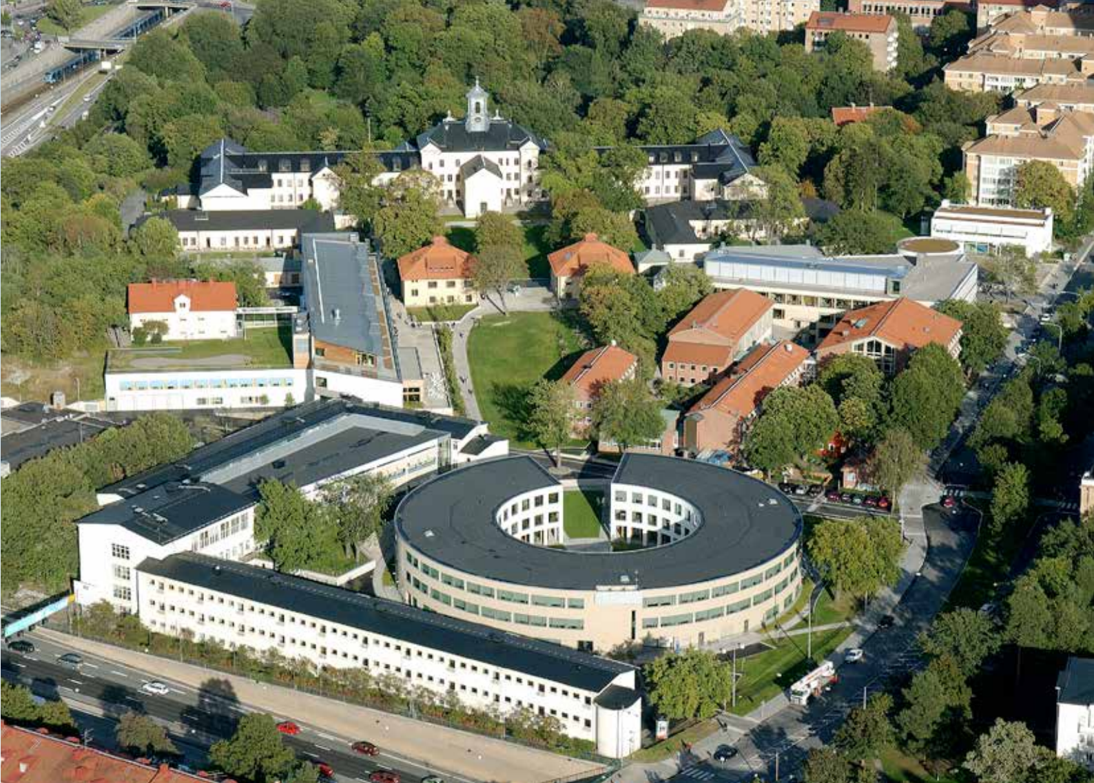
Skolkomplexet Campus Konradsberg i Stockholm värms av överskottsvärme från Telias datacenter i Fredhäll. Foto: Skolfastigheter i Stockholm.
