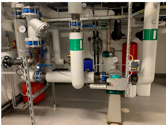
Huvudcirkulationspump för värme och kyla samt växlare för kyla till husen
