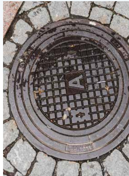
Ett oansenligt brunnlock vid en av entréerna skvallrar om geoenergianläggningen vid Triangeln köpcentrum i Malmö.
