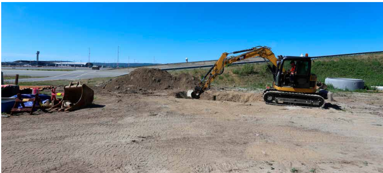
På en uppställningsplats för flygplan på Gardermoen utanför Oslo har två brunnar på vardera 1 500 meters djup borrats för att användas till snösmältning.
