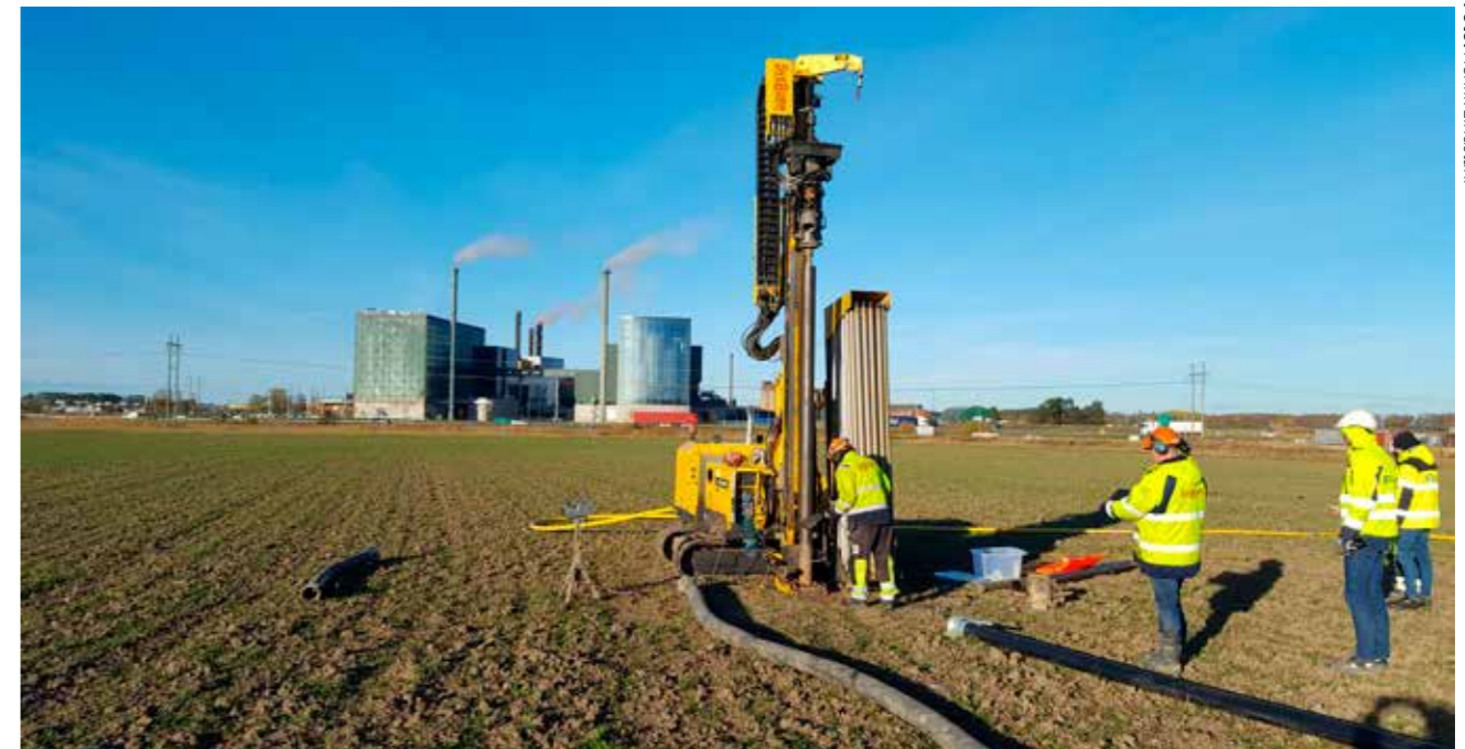
I Linköping har Tekniska Verken inlett provborrningar för ett högtemperaturlager där värme från sommarens avfallsförbränning ska kunna lagras.
