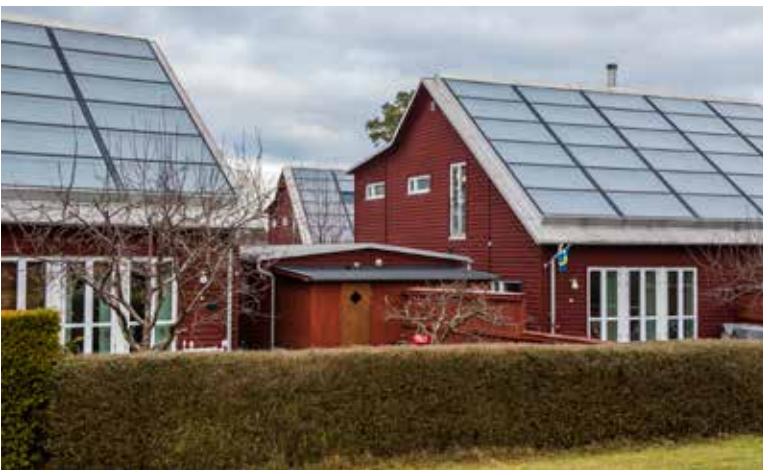
Under vinterhalvåret hämtas lagrat varmvatten från sommarens solvärme upp från berget för att värma husen i Anneberg.
