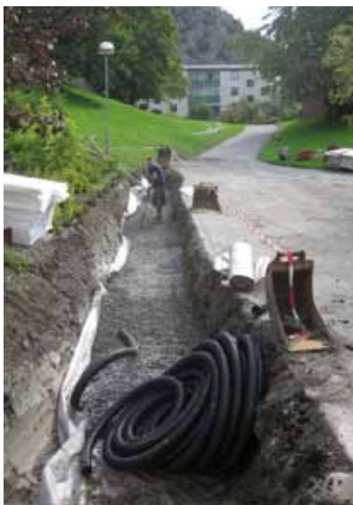
Geoenergianläggningen hos Brf Agnesberg fick nya slangar 2009.
