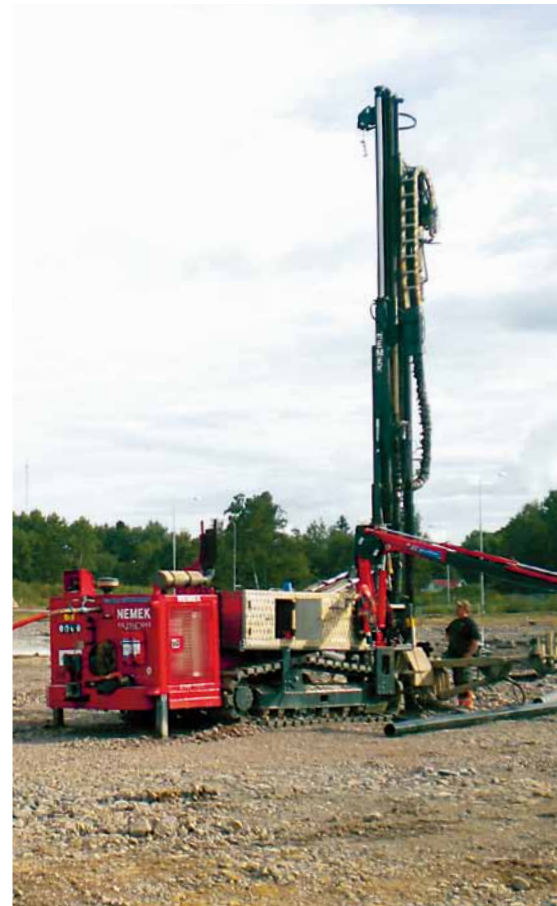
Här borras för geoenergi i Biltemas senaste anläggning i Motala.
