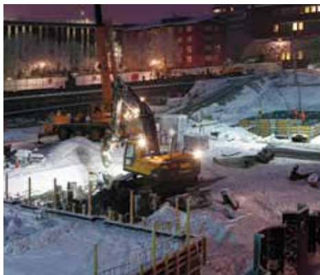
På en gammal parkeringsyta mitt i Norrköping bygger nu Lundbergs ett hyreshus med geoenergi.
