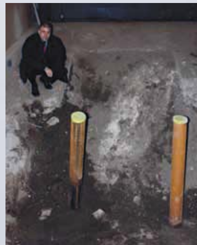
Två borrhål ska försörja de 3.200 kvadraten med värme. Geoenergin är lätt att använda i Malmö, eftersom det finns mycket stor tillgång på grundvatten, säger Erik Hagman.
