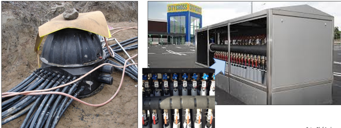
Figur. 4. Alternativ för parallellkopplade energibrunnar. T.v. samlingsbrunn under mark. T.h. markuppställt samlings-skåp. Detaljbild visar injusterings-och avstängningsventiler.
