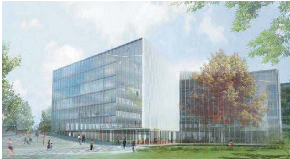
Bild 2: "Kristallen" i Lund- en förvaltningsbyggnad med höga krav på energieffektivitet förses med geoenergi (källa: Christensen & Co Arkitekter AS, Köpenhamn)
