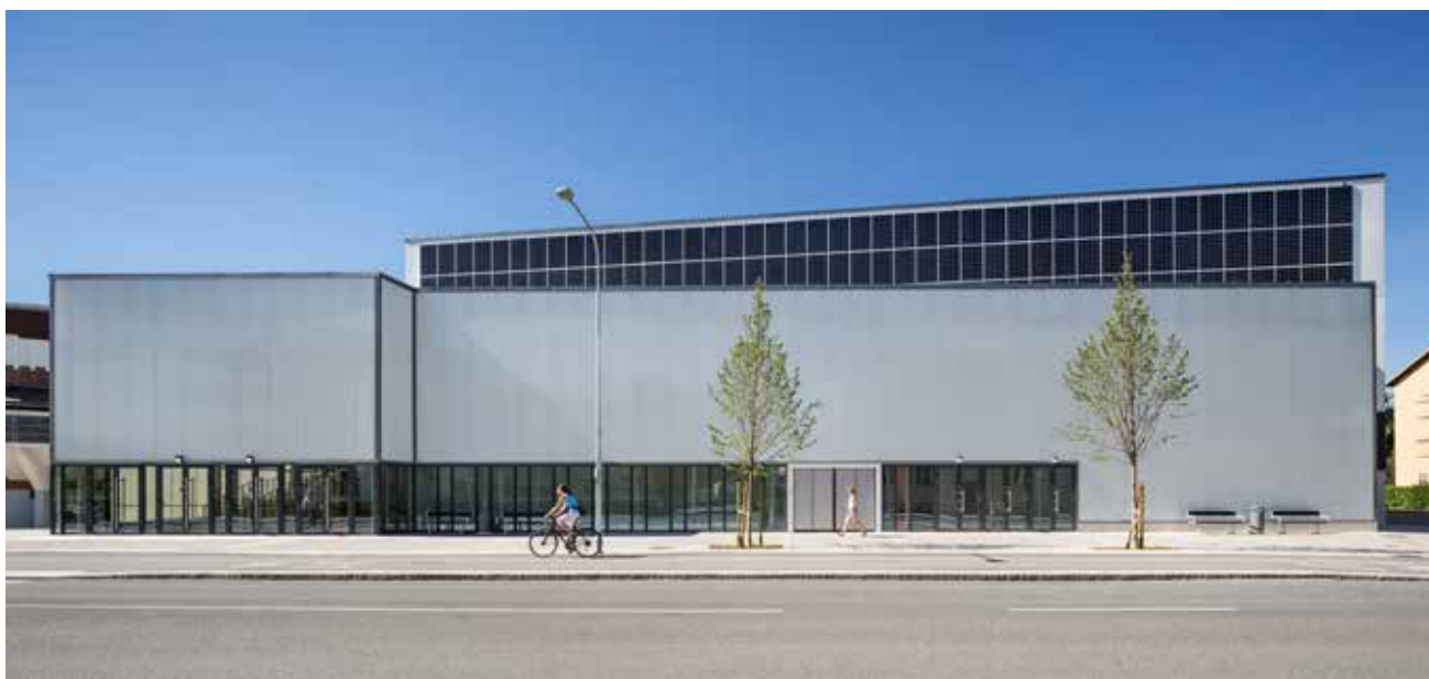
Multiarenan Fyrishov i Uppsala kombinerar geoenergi med sol- och vindkraft. Foto: Stig Jansin.
