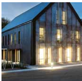
Väla gård, Helsingborg Bergvärme
