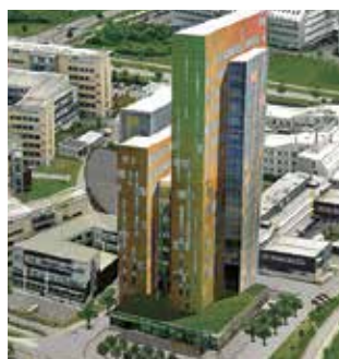
Ideon Gateway, Lund Bergvärme
