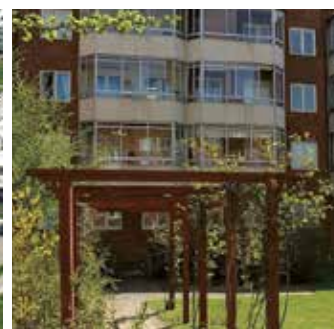
Brf Friheten, Malmö Grundvattensystem
