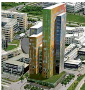
Ideon Gateway, Lund Bergvärme
