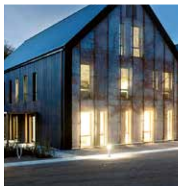
Väla gård, Helsingborg Bergvärme
